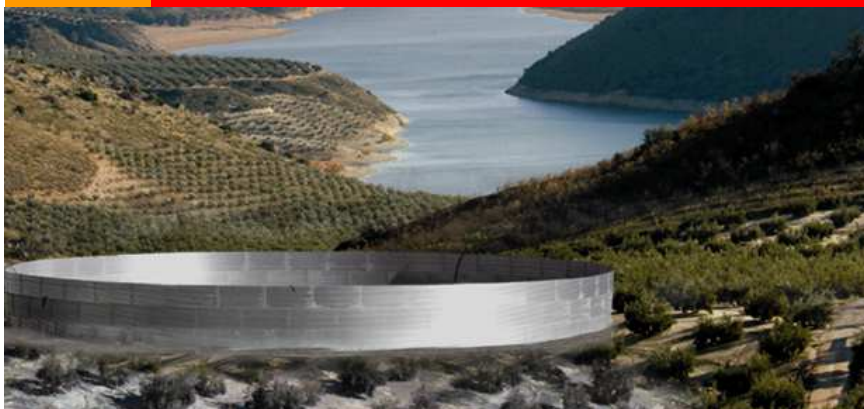
REZERVOARE DE APA CU BAZA DIN BETON
